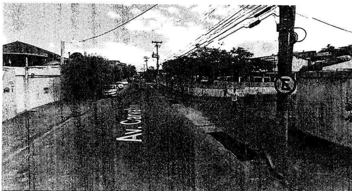
BUEIRO AVENIDA CARVALHO, INÍCIO DA RUA CEL ARMANDO RIBEIRO, BAIRRO SANTA TEREZA
