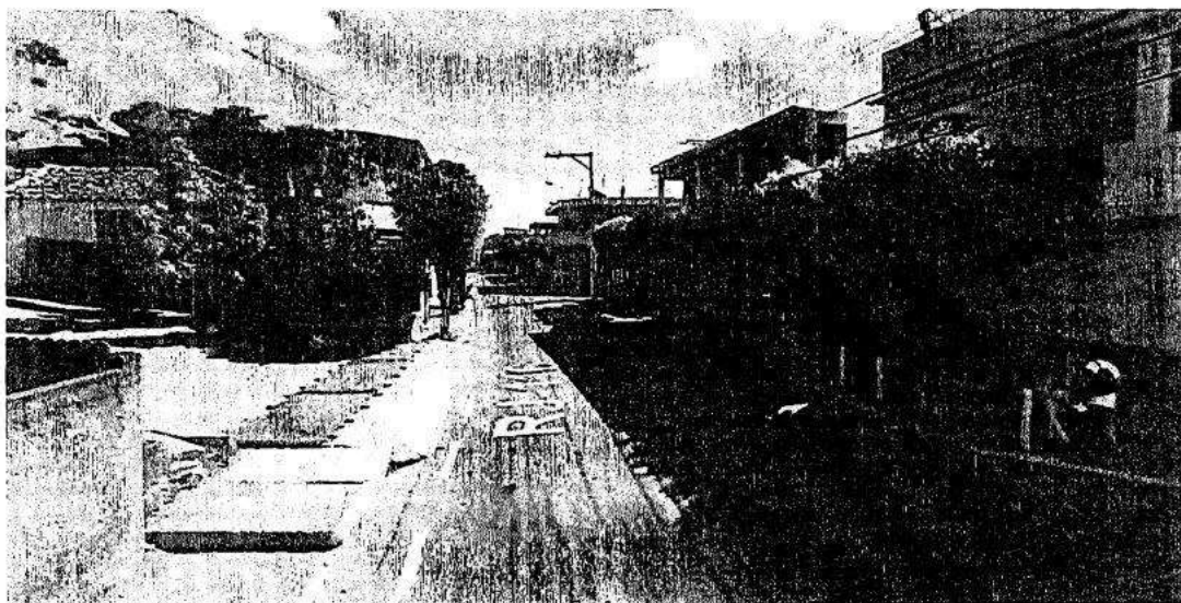
TRECHO ESTREIRO DA RJ-117, AVENIDA NILO PEÇANHA, A SAÍDA DO LOTEAMENTO VISTA ALEGRE, À ESQUERDA, PELA RUA GELÚLIO GARCIA BASTOS - FALTA DE VISIBILIDADE.
