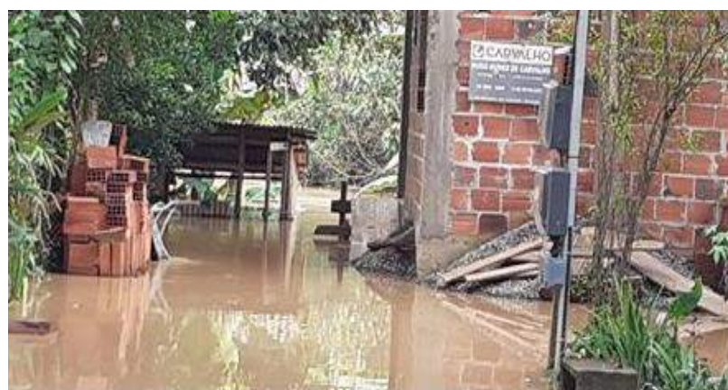
Figura 40. Ponto de alagamento na Comunidade do Conde. Fonte: Defesa Civil de Miracema, 2020
