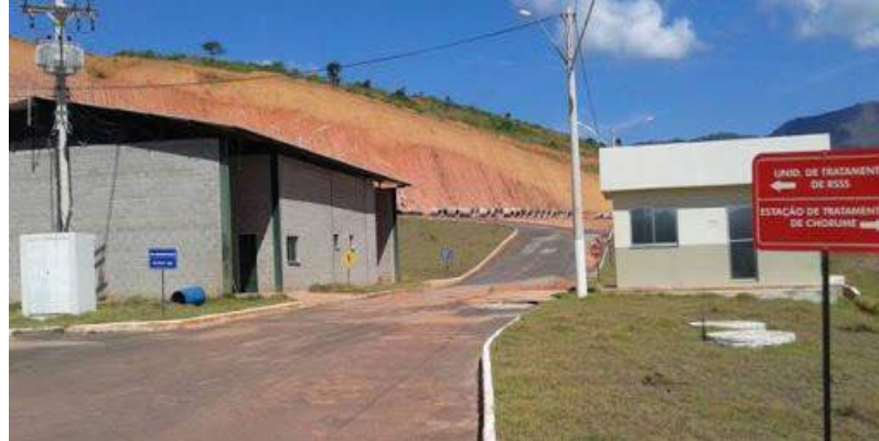
Figura 45. Entrada do aterro sanitário São Fidélis. Fonte: Arquivo da Prefeitura, 2020.
